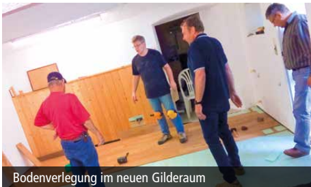
Bodenverlegung im neuen Gilde Raum
