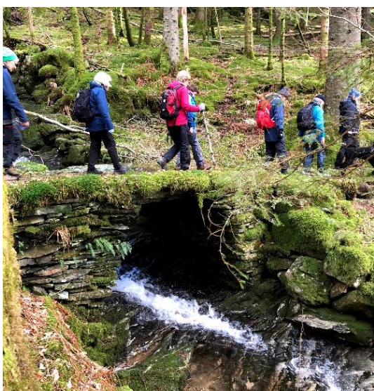
Utkragebro ved Nilsaplassen
